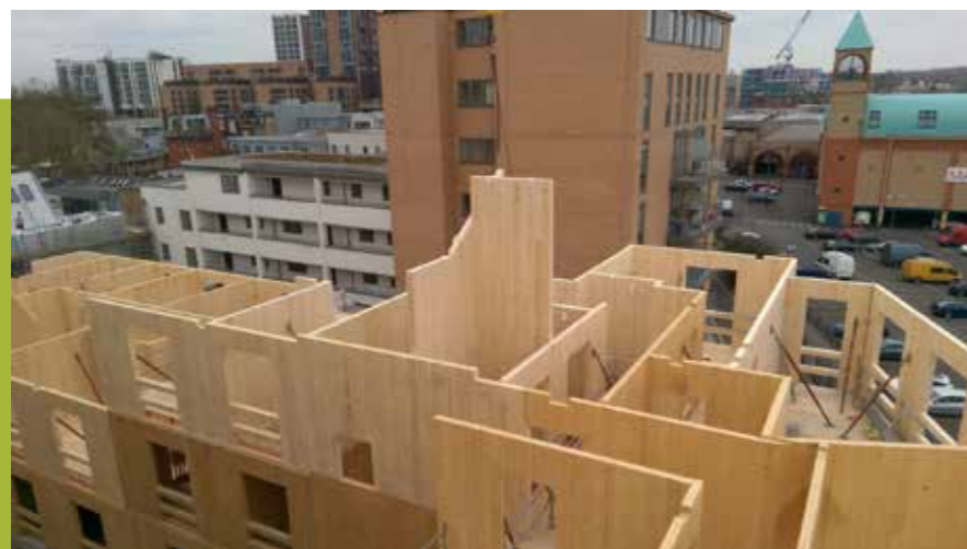
Edifício CLT em Dalston Lane Waugh Thistleton
